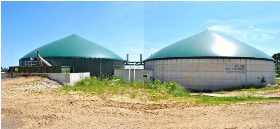
Figure 134 : méthaniseur de la ferme Dufour à Verderel-lès-Sauqueuse (Source : site internet CERDD)
