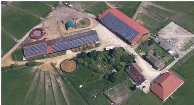
Figure 132 : photographie aérienne de l'installation photovoltaïque du haras du bois d'argile à Berneuil-en-Bray (source : Googlemap)
